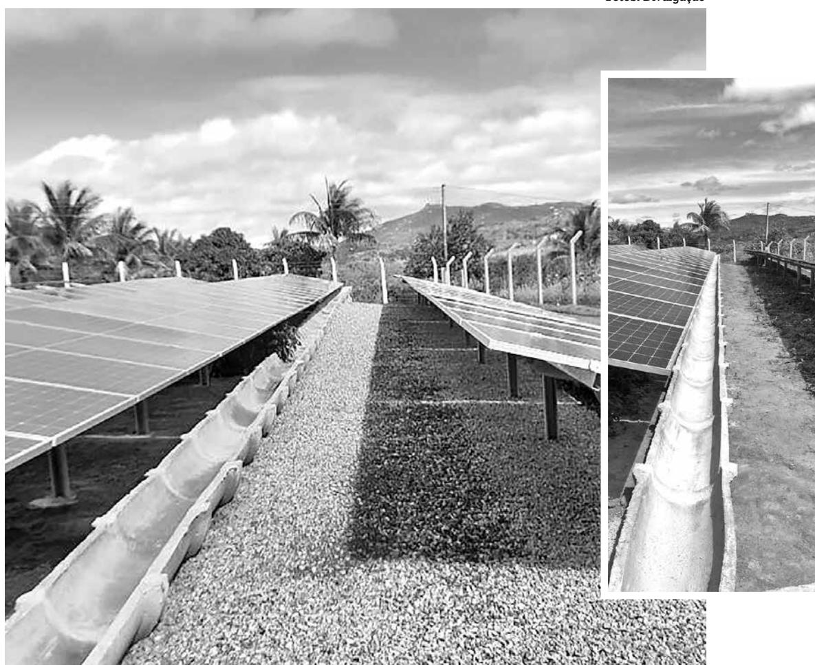
A cooperativa apresenta um sistema para recolher água da chuva a partir das placas fotovoltaicas
